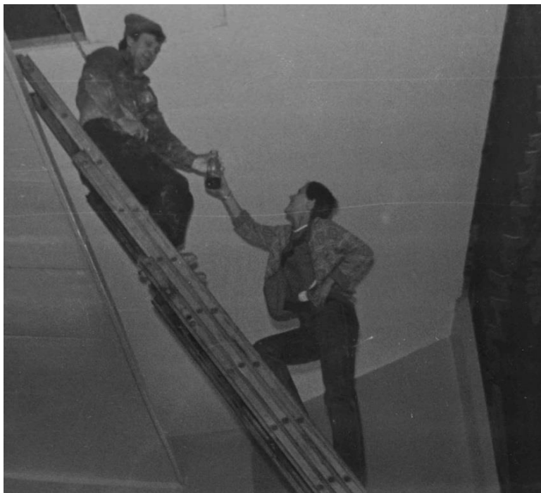
Ремонтные работы в кинотеатре «Арктика», 1985 г.
